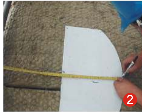
2.確認端板焊接位置
