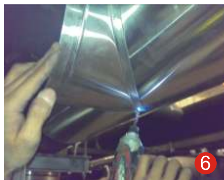
6.安裝時須符合弧度並緊密堅固美觀後鎖上螺絲。
